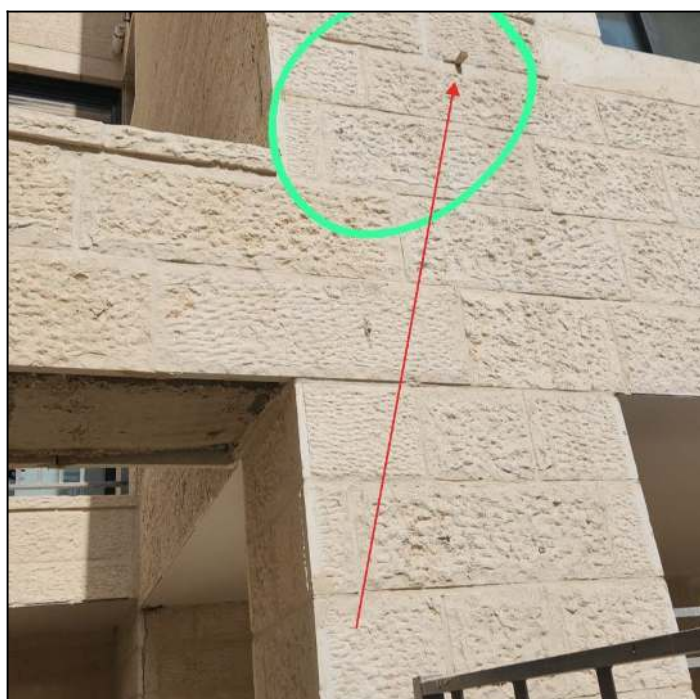
קומה 0 - יש להוציא את הקלין ולמלא בכוחלה - יכול להוות מקור לחדירת מים בעתיד
